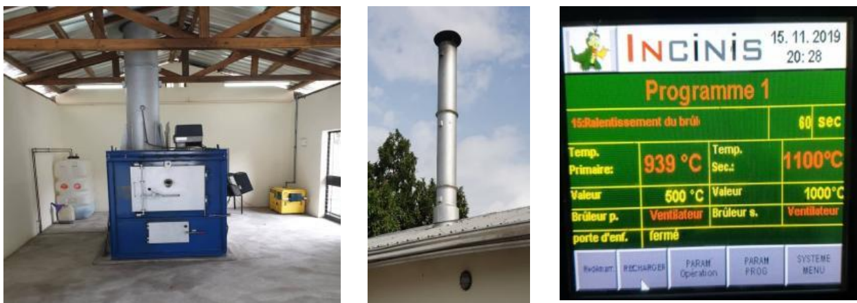
Figure 1 : Incinérateur de marque « Incinis » installé dans le CMA d'Etoa, District de Santé d'Efulan (en pleine opération de combustion des déchets)
