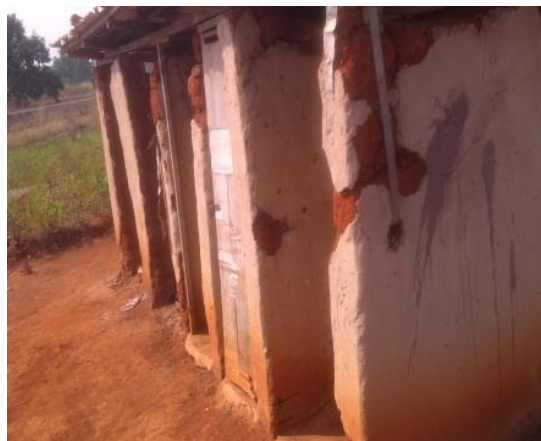
Latrine de Babessi
