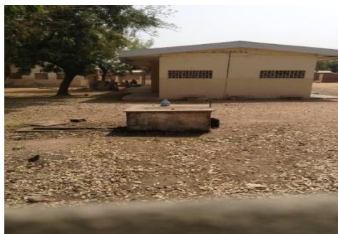
CMA de LAINDE (pas de clôture)
